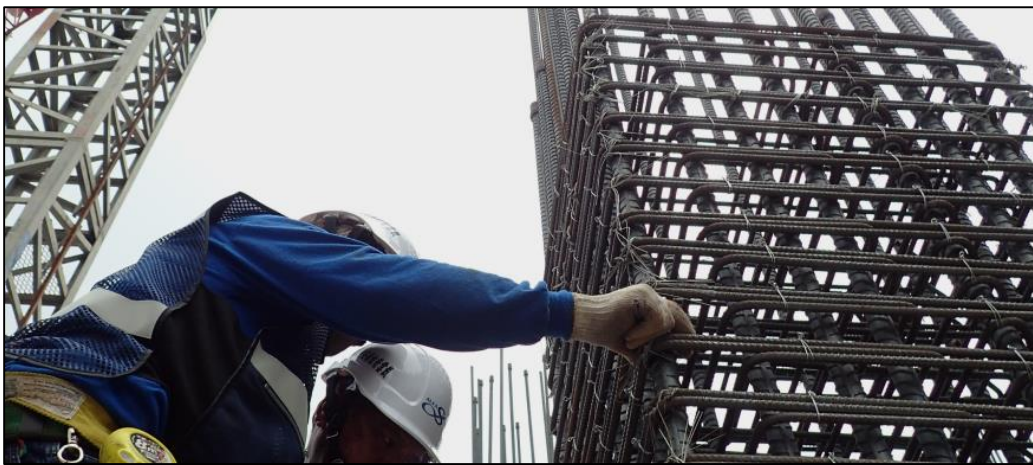
圖 2-3 鋼筋綁紮圖
